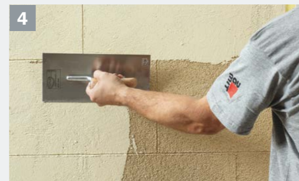
4 Anschliessend wird die Kornstruktur mit Baumit CreativTop Pearl im Farbton 0217 annähernd flächendeckend ohne Berücksichtigung der vorgezogenen Fugen aufgefüllt und nach anstreifen nochmals mit unter leichtem Druck nachgeglättet bzw. mit Stahltraufel verrieben. Fehlstellen bzw. Luftporen tragen zur Imitierung einer Sandsteinoberfläche bei.
