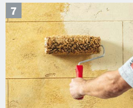
7 Baumit Lasur im Farbton 735L auftragen ...
