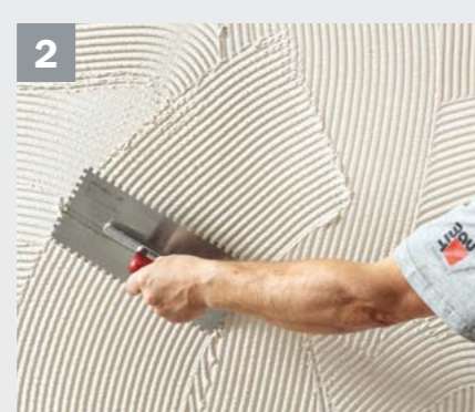
Nach ausreichender Trocknung wird eine weitere Schicht Baumit CreativTop Fine aufgezogen und mit einer rostfreien Zahntraufel (Zahnung 8 mm) durchkämmt und gegebenenfalls grob abgeglättet.
