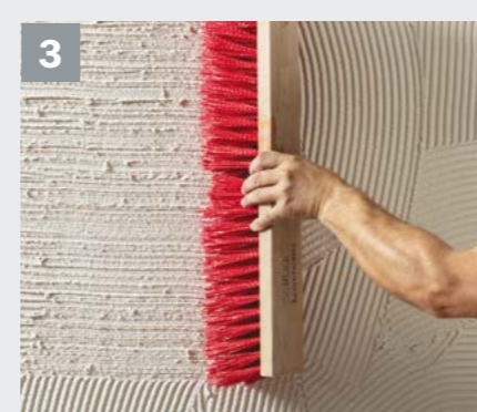
Unmittelbar danach erfolgt die Strukturierung der Oberfläche mittels Besen. Eine Feldbegrenzung ist vorzunehmen, wenn aufgrund der örtlichen Gegebenheiten keine unterbrechungsfreie Strukturierung der Gesamfläche erfolgen kann.
