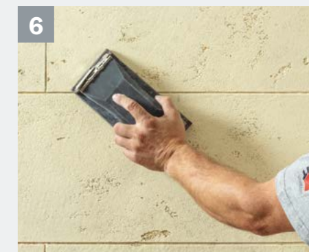
6 Nach einer Standzeit von 24 Stunden* wird die Fläche und die Fugen grob mit Schleifpapier Körnung 16 überschiffen.
