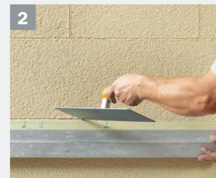
2 ... und das Fugenbild gemäss Fugenplan in der gewünschten Fugenbreite erstellt. Hier empfiehlt sich die Verwendung einer H-Kartätsche unter Zuhilfenahme eines Kunststoffreibbretts.
