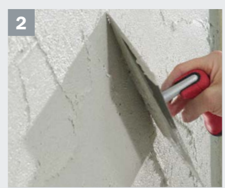
Der noch frische CreativTop wird mit einer rostfreien Stahltraufel nach Wunsch strukturiert.
