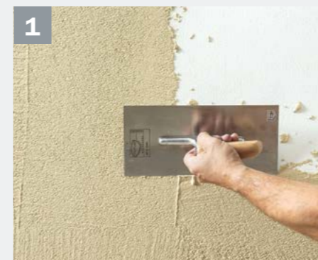
1 Baumit SilikonTop K 1,5 im Farbton 0185 wird mit einer rostfreien Stahltraufel vollflächig aufgezogen und verrieben....
