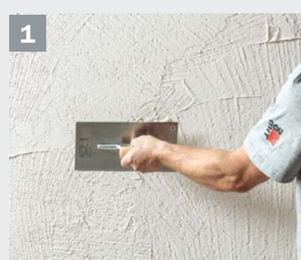
Baumit CreativTop Fine wird im gewünschten Farbton in Kornstärke auf den Untergrund aufgezogen.
