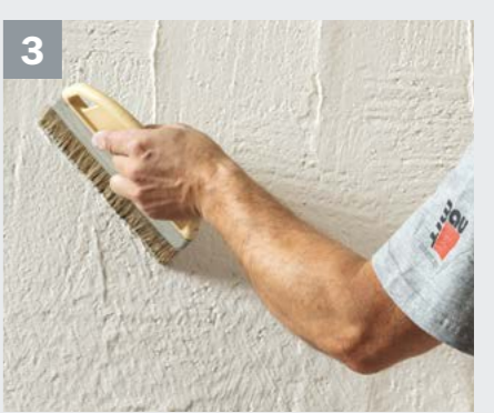
Anschließend wird die noch frische, aber bereits leicht angezogene Oberfläche mit einer feuchten Malerbürste oder einem feuchten Schwamm geschlämmt. Dadurch werden die vorhandenen Grate abgeflacht.
