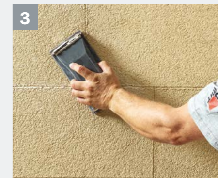
3 Nach einer Standzeit von 24 Stunden* werden die Flächen und die Fugen grob mit Schleifpapier Körnung 16 überschiffen.
