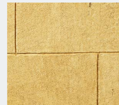
Fertig gestellte Sandsteinoptik.
