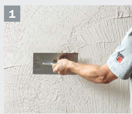
Baumit CreativTop Trend wird im gewünschtem Farbton in Kornstärke auf den Untergrund aufgezogen ...
