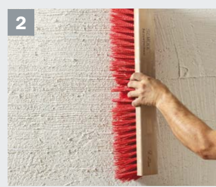
... und mittels Besen strukturiert.
